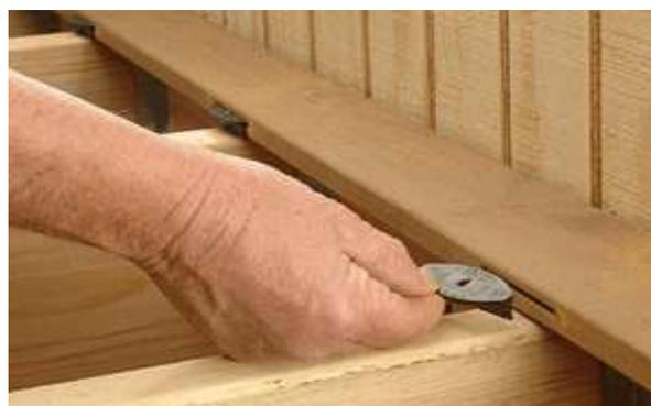
Разместите EB-TY® (ип-тай) крепления в выемках при каждом пересечении с балкой. Установите по одному нержавеющей шурупу с узкой шляпкой в каждое крепление под углом в 45 градусов.
