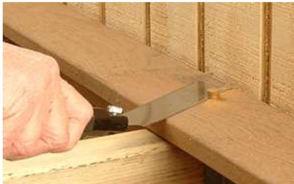
Аккуратно удалите выступающую часть деревянной заглушки, используя небольшую пилу либо ленточно-шлифовальный станок.
